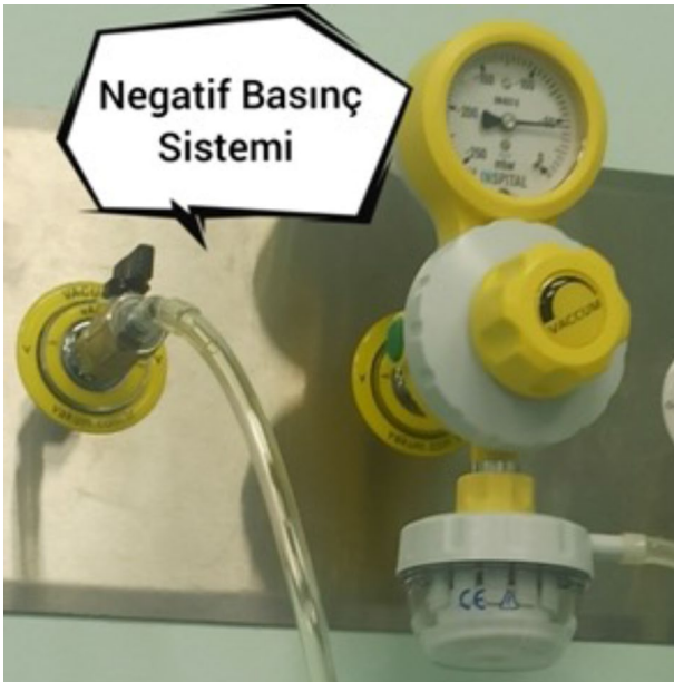
Şekil 10. Negatif Basınç sistemi. Rezarvuar ve ototransfüzyon sisteminin negatif basınç modülleri.
